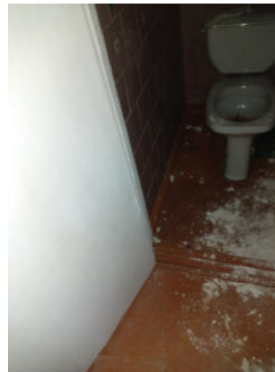
14.attēls. Tualete (telpa Nr.6)
