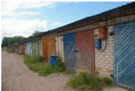
Būve (garāžas ēka) ar kadastra apzīmējumu 1700 002 0135 008
