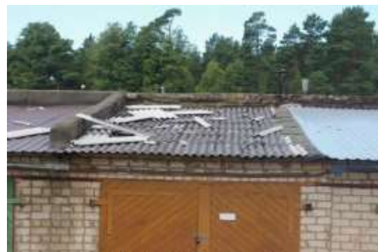
Būve (garāžas ēka) ar kadastra apzīmējumu 1700 002 0135 008, garāža Nr.268, jumts
