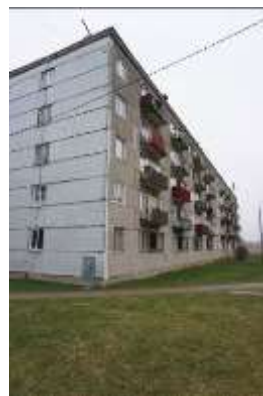
Daudzdzīvokļu dzīvojamās ēkas fasāde
