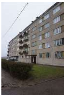
Daudzdzīvokļu dzīvojamās ēkas fasāde
