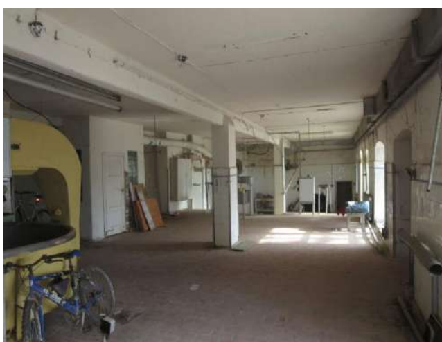
1.stāva ražošanas telpa
