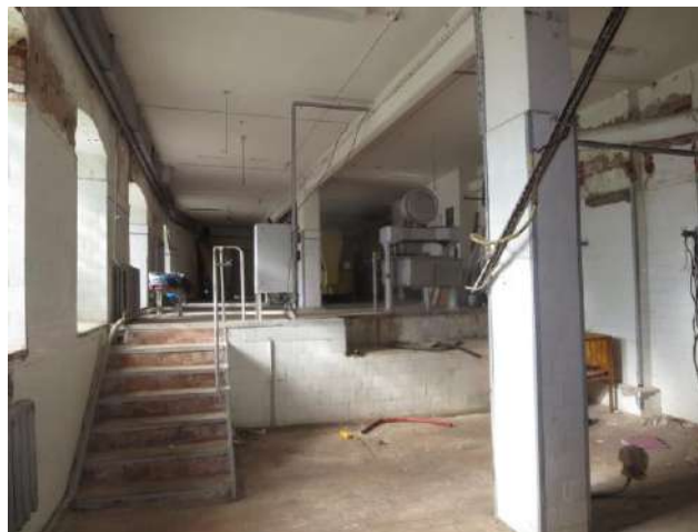
1.stāva ražošanas telpa
