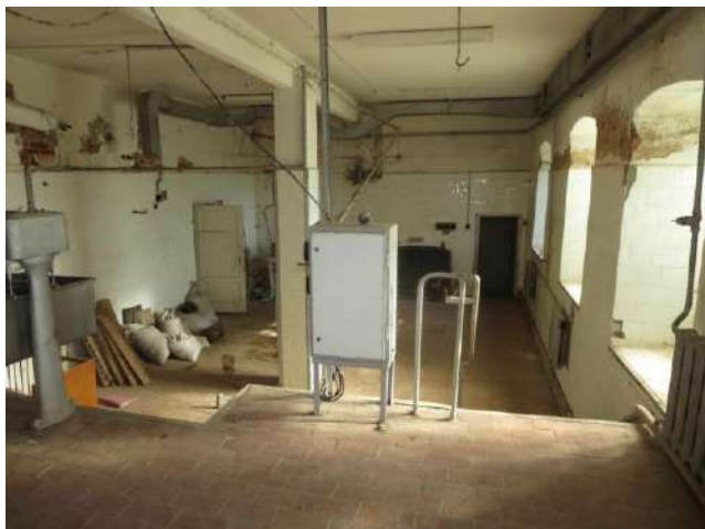
1.stāva ražošanas telpa
