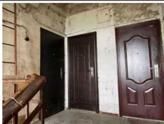
2.stāva kāpņu telpa
