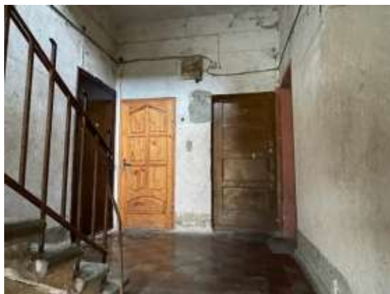
1.stāva kāpņu telpa
